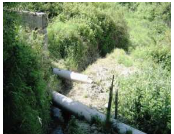
Figura 45 – Precario stato manutentivo delle opere di drenaggio che attraversano la porzione di piede della frana di San Martino di Finita
