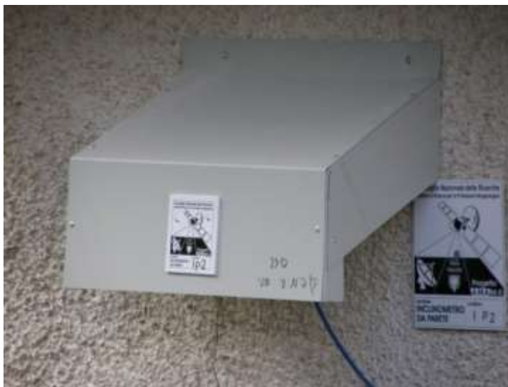
Figura 32 Particolare della protezione in alluminio realizzata per la protezione degli inclinometri dall'irraggiamento solare.
