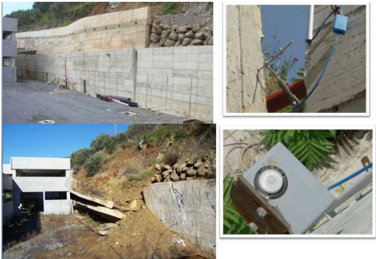
Figura 50 – Loc. Palazuolo-Sceuzza di Cetraro: installazione dei sensori del sistema AMAMiR sul muro di sostegno pericolante prima del collasso (marzo 2008) e collasso del muro (gennaio 2009)
