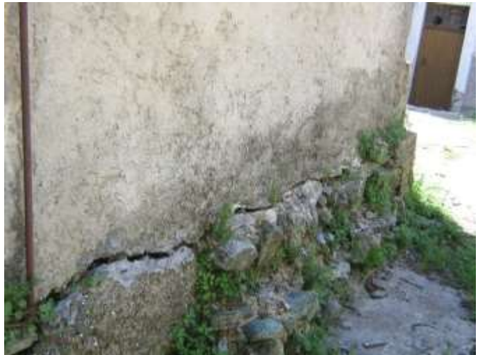
Fig.15–frattura sub-orizzontale che interessa la base di un edificio privato.
