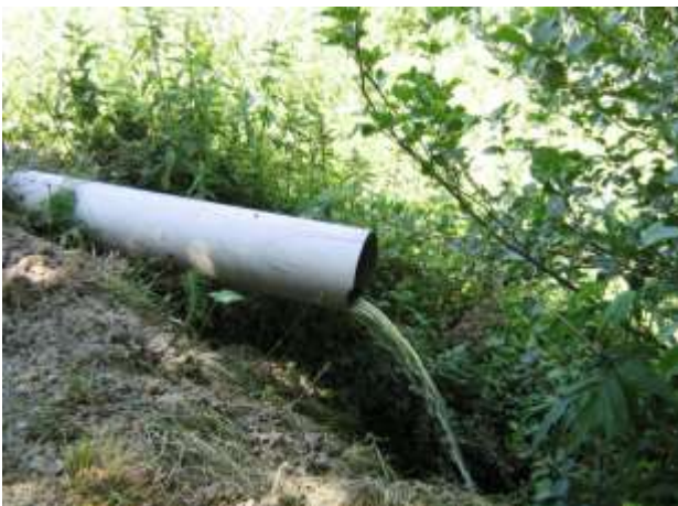
Figura 45 – Precario stato manutentivo delle opere di drenaggio che attraversano la porzione di piede della frana di San Martino di Finita
