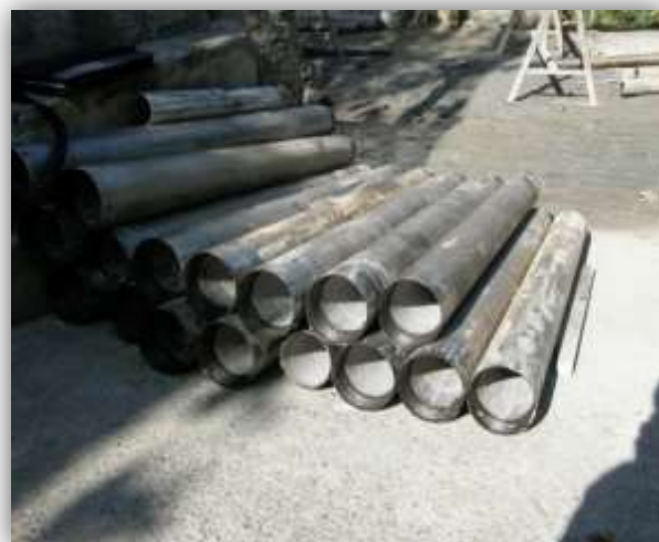
Fig. 11 – Tubi metallici di rivestimento utilizzati durante la perforazione
