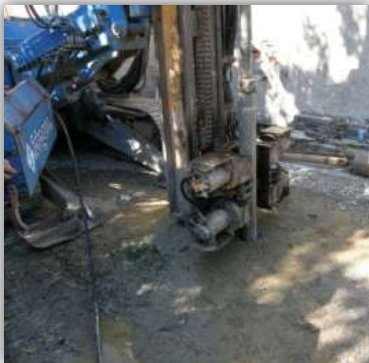
Fig. 11 – Tubi metallici di rivestimento utilizzati durante la perforazione
